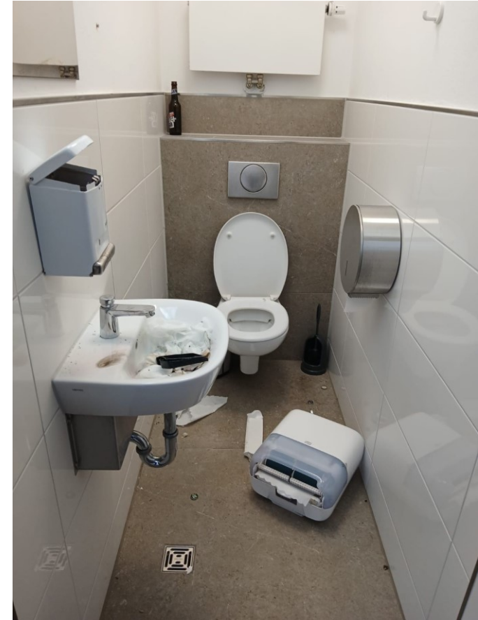
WC Anlage „Strandkiste“
